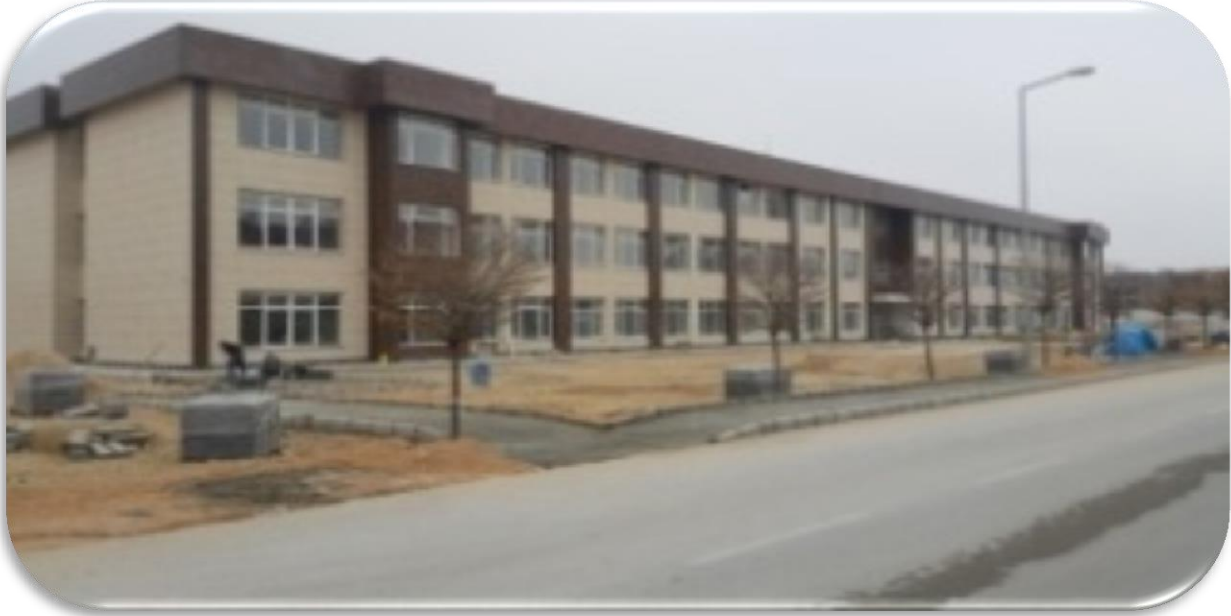
Çizelge 99: Çarşı Binası Yapım İşİ İşİ ve İ.İ.B.F. Ek Amfi Bloğu inşaatı
