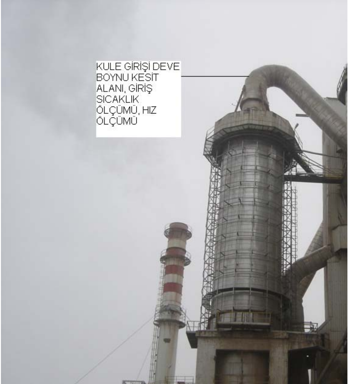
Fotoğraf 3.2 Soğutma kulesinin programa aktarılacak önemli parametreleri
