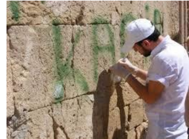
Tarihi bir yapıda bozunmuş kaplama taşının incelenmesi
