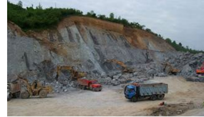
Yol yapım çalışması
