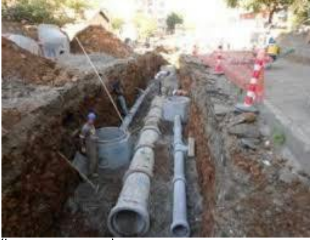
Boru hattı çalışması
