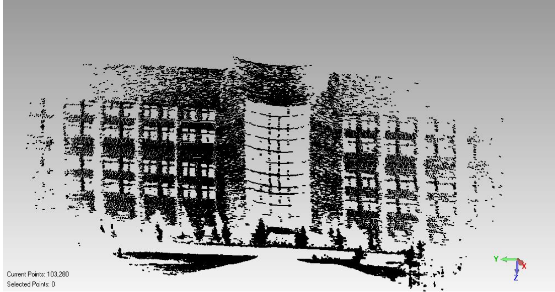
Şekil 6.2 Mühendislik Fakültesi Arkası B Blok Giriş Tarafı
