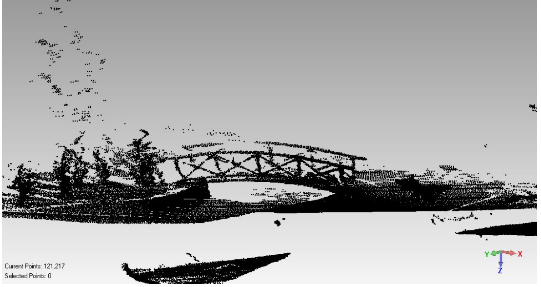
Şekil 6.4 Yemekhane Tarafında Ağaçlık Alanda Bulunan Köprü
