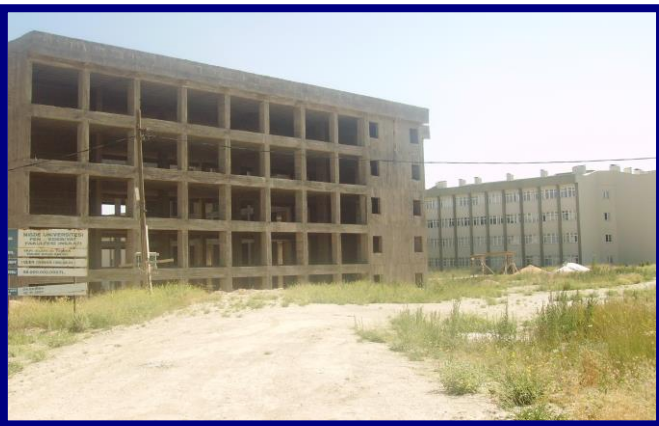
Fen-Edebiyat Fakültesi inşaatından Görünüm
