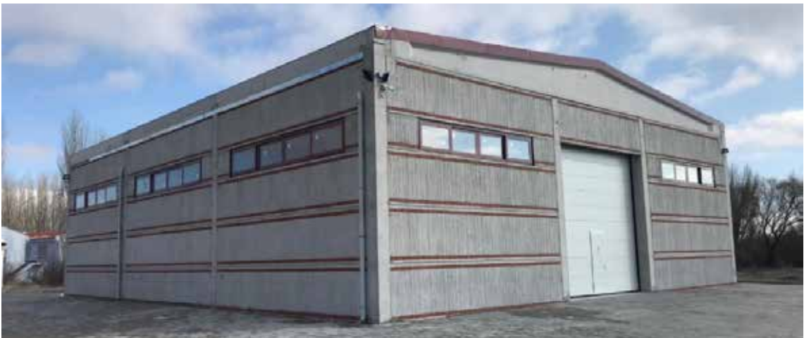
Geçici atık depolama binası
