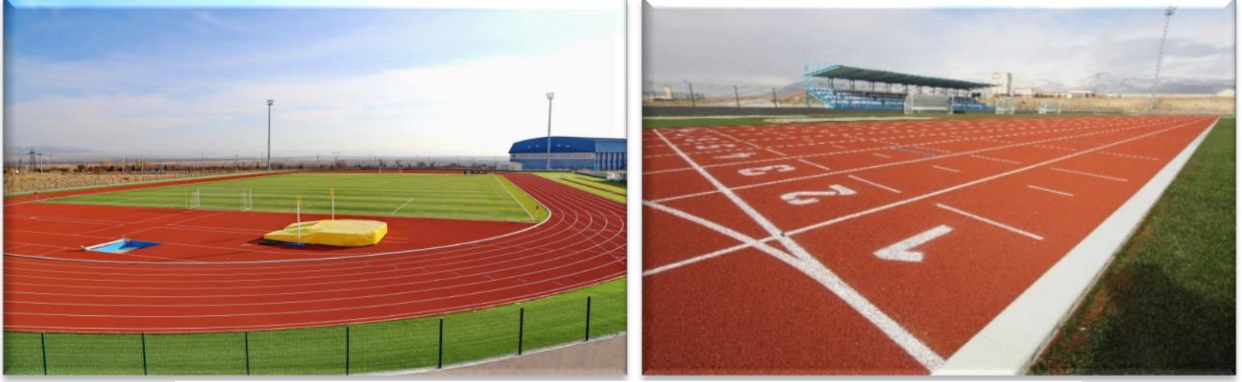
Resim-1. Atletizm-Futbol Sahası (SBF Yerleşkesi)
